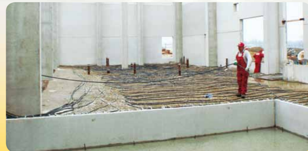
Overflatevarmeren HSH 700 bringer betong til den ideelle herdetemperaturen på 18 - 24 °C, og sparer dermed tid og penger.
