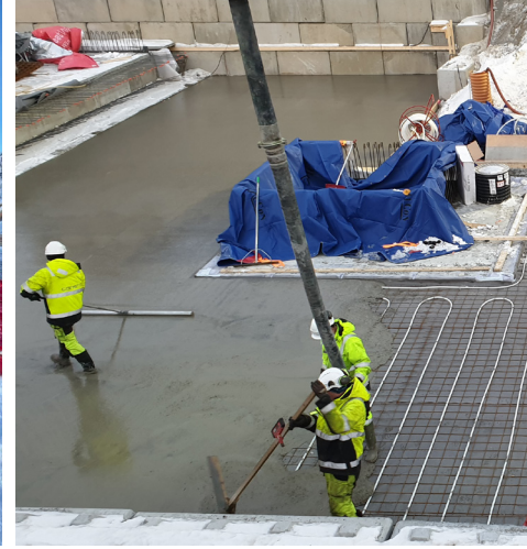
Tilførsel av varme i betong - reduser herdetid med 85%
